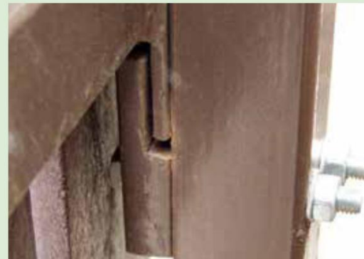
Detail úchytky s fixačnou skrutkou
